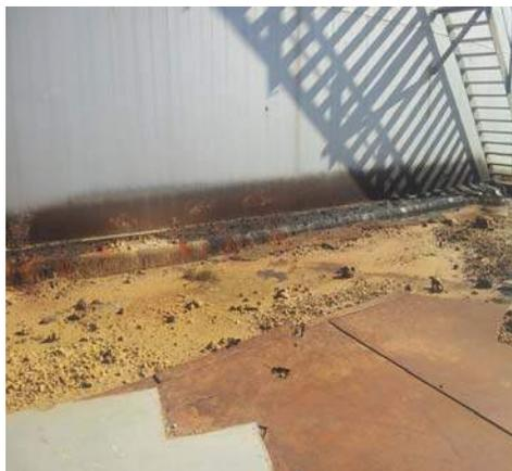
Photos 1 et 2 - Traces des fuites d'hydrocarbures des fonds de bac de Brut (S10) pendant les travaux de réparation du fond de bac
